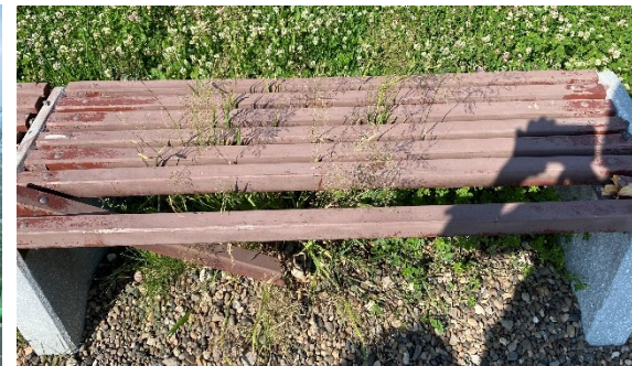
Краска (окрашено в 2 слоя), не сохранилась (стерлась) по истечении 12 месяцев с момента проведения работ
