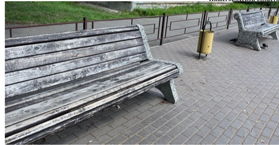
Краска (окрашено в 2 слоя), не сохранилась (стерлась) по истечении 12 месяцев с момента проведения работ
