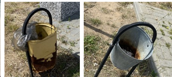
Лавочки, урны, оборудование не ремонтировали
